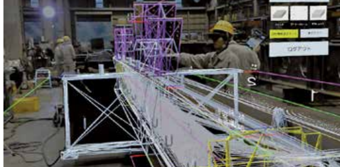
図1. 3D CADで作られた建物のバーチャル映像を元に図面レスで部品の取付位置、情報を確認
